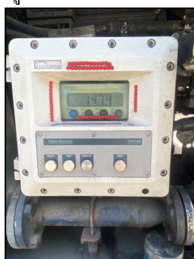
รูปที่ 3-25 ระบบตรวจสอบปริมาณการส่งและรับผลิตภัณฑ์จากบริษัทคู่ค้า (LPG)
