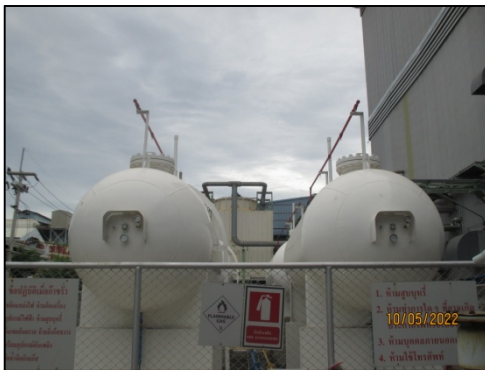
รูปที่ 3-26 Remote Shut-off-Valve ของก๊าซ LPG
