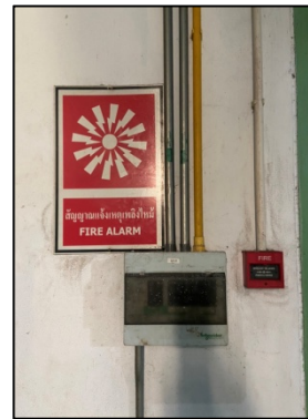
รูปที่ 3-21 ระบบสัญญาณแจ้งเหตุฉุกเฉิน
