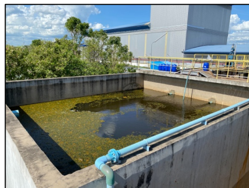
รูปที่ 3-5 บ่อพักน้ำทิ้งที่ผ่านการบำบัด (Effluent Pond)
